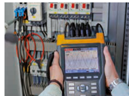
Medición de energía Energy measurement
