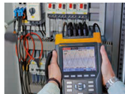
Medición de consumo eléctrico Energy measurement
