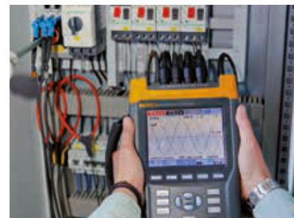
Medición energética Energy measurement
