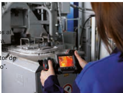
Análisis termográficos Thermographic analysis
